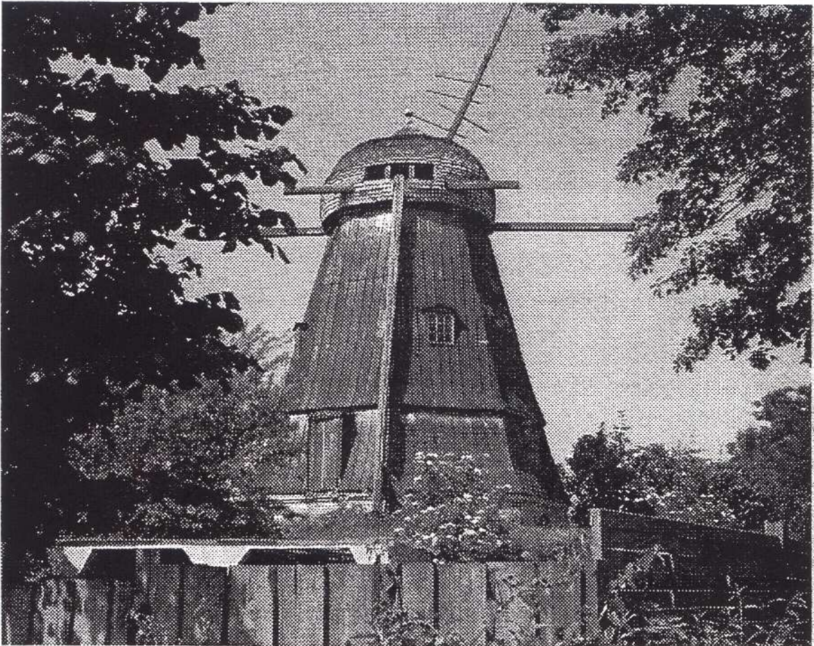
Billede taget umiddelbart før påbegyndelse af nedtagningen i 2000
